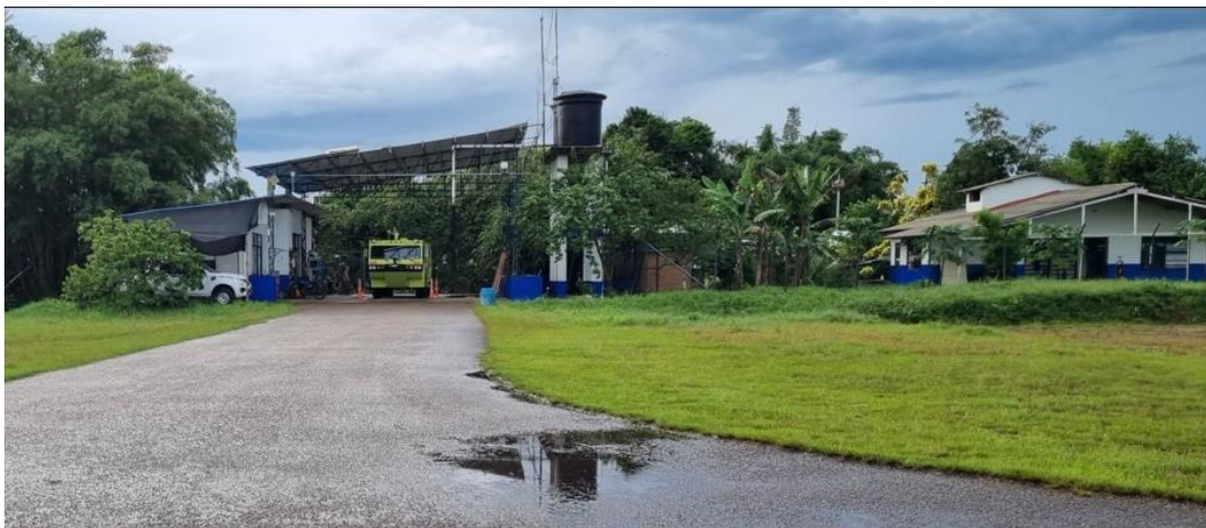
Base Servicios de Extinción de Incendios SEI
